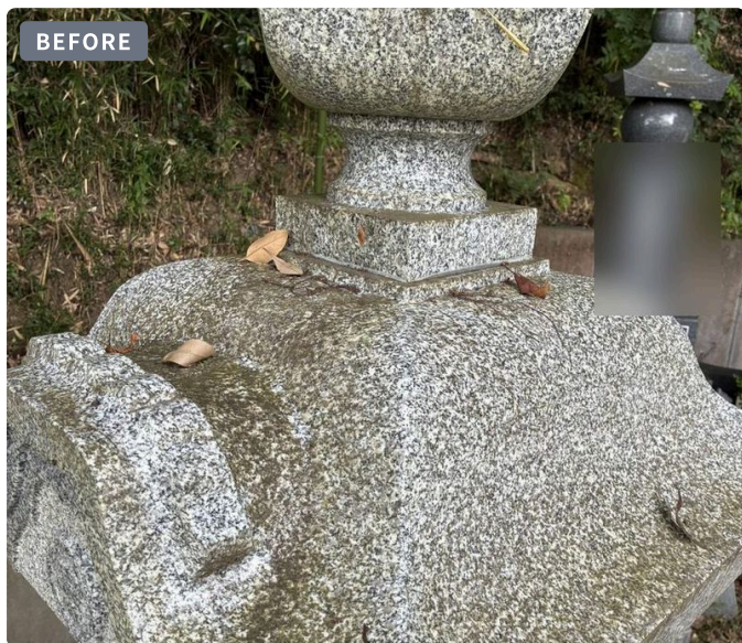
⑩ 作業前 | 灯籠の宝珠・笠部分（細部） 灯籠屋根部分の凹みに落ち葉やコケが固着していた状態。
