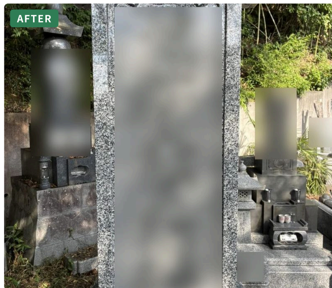
⑦ 作業後 | 竿石正面の文字彫刻 彫刻溝の深部まで細ブラシで手磨きし、鮮明な文字に仕上げ。
