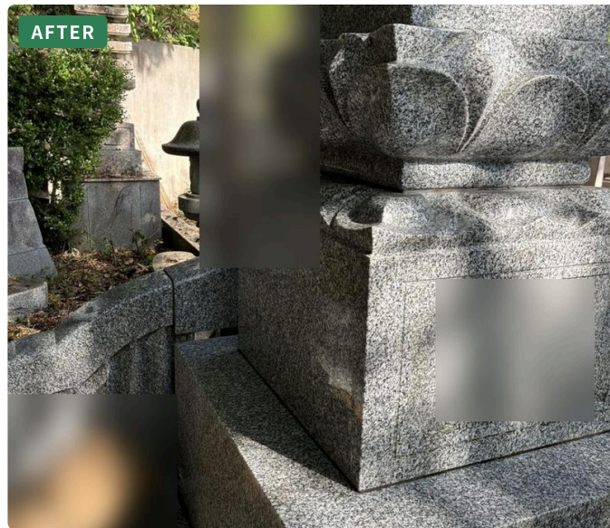
⑧ 作業後 | 竿石・蓮華台座の左側面 石肌を傷めない専用洗剤で、側面の黄ばみ・雨ジミを手磨き。
