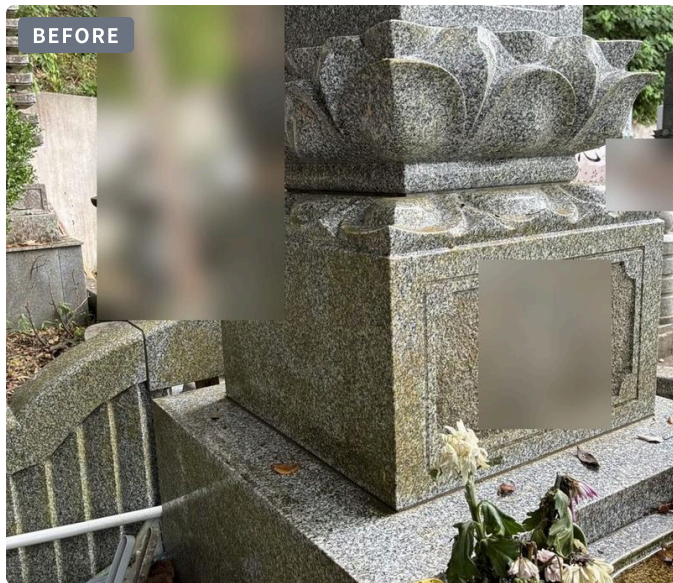
⑧ 作業前 | 竿石・蓮華台座の左側面 風雨による雨ジミ・黄ばみが蓮華彫刻や台座側面に付着。
