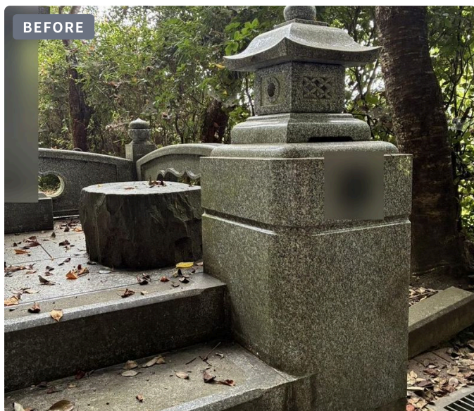
③ 作業前 | 右側灯籠・アプローチ階段 階段周りに落ち葉が溜まり、灯籠台座に苔が付着。
